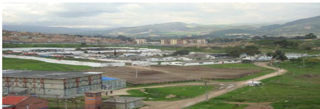
Figura 6. Panorámica ERON segunda generación, estructura 2, pabellón justicia y paz COMEB. Fuente: INPEC galería (2012).
