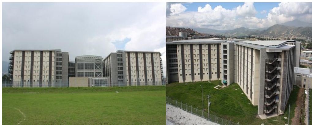
Figura 7. Panorámica ERON tercera generación, estructura tres COMEB. Fuente: INPEC galería (2012).
