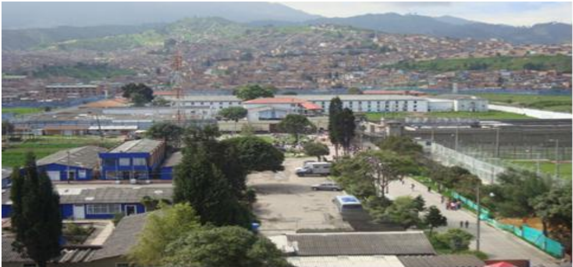
Figura 3. Panorámica ERON primera generación, estructura 1 COMEB. Fuente: INPEC galería (2012).
