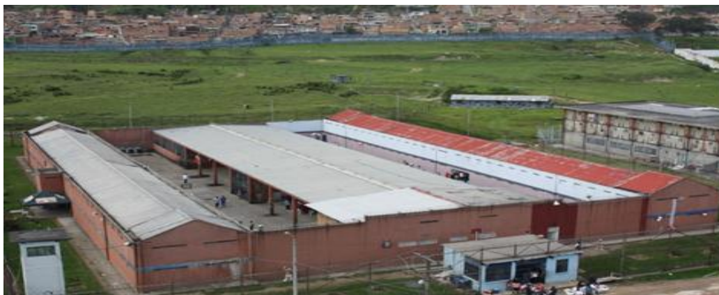
Figura 5. Panorámica ERON segunda generación, estructura 2, pabellón funcionarios públicos COMEB. Fuente: INPEC galería (2012).
