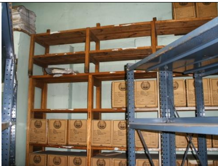
Estantería inadecuada en madera- archivo central
