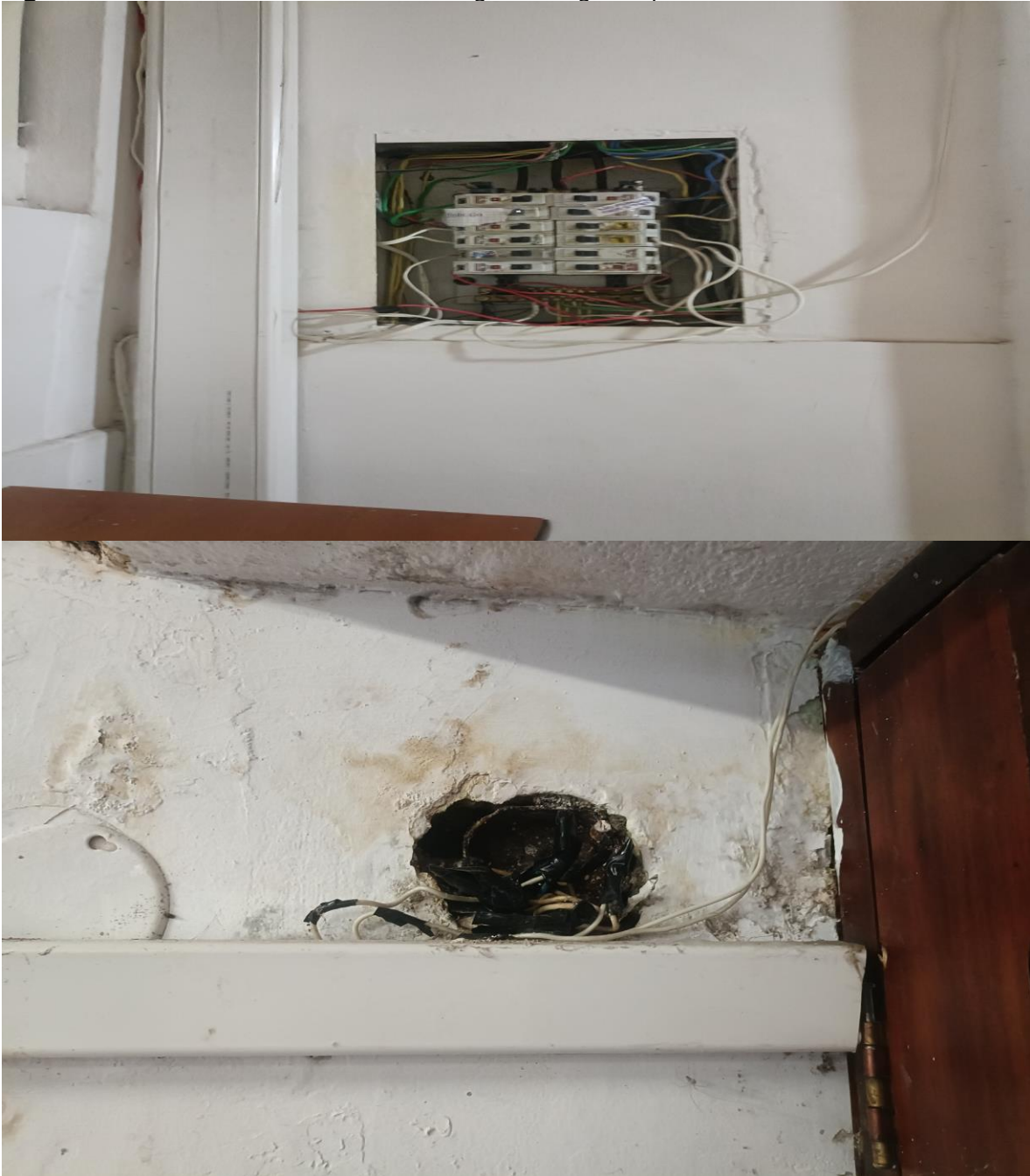
Figura No. 3. Conexiones eléctricas de gran riesgo de provocar incendio en el ERON
